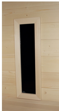
Abb. 42: Blende der Rückenstrahler montieren
