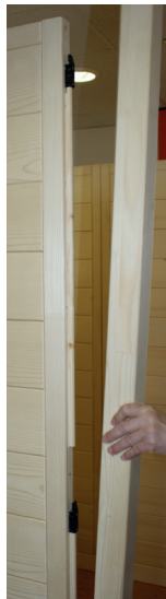
Abb. 9: Montage der beiden vorderen Ecksteher mit Nut für Glas
