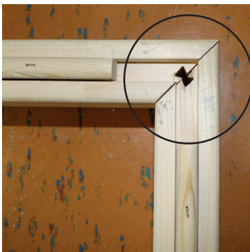
Abb. 2: Bodenelemente verbinden
