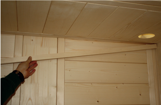
Abb. 37: Montage der LED-Abdeckleiste
