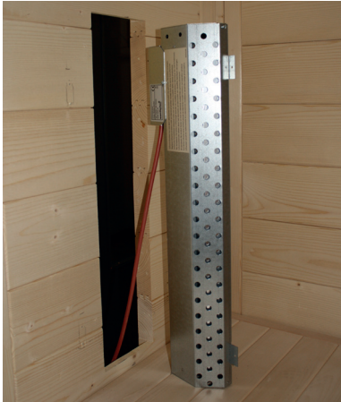
Abb. 41: Rückenstrahler (Infrarot-Strahler ECO 350) montieren
