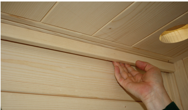
Abb. 38: Einkleben des LED Stripes
