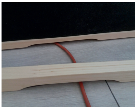
Abb. 35: Einsetzen der Aussteifungsleiste für IR-Wärmeplatten VitaMy
