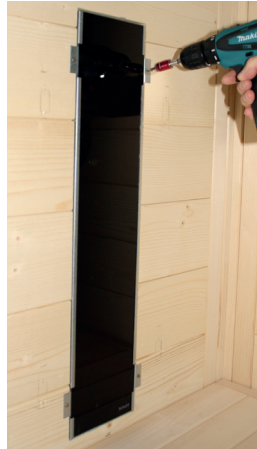
Abb. 41: Rückenstrahler (Infrarot-Strahler ECO 350) montieren
