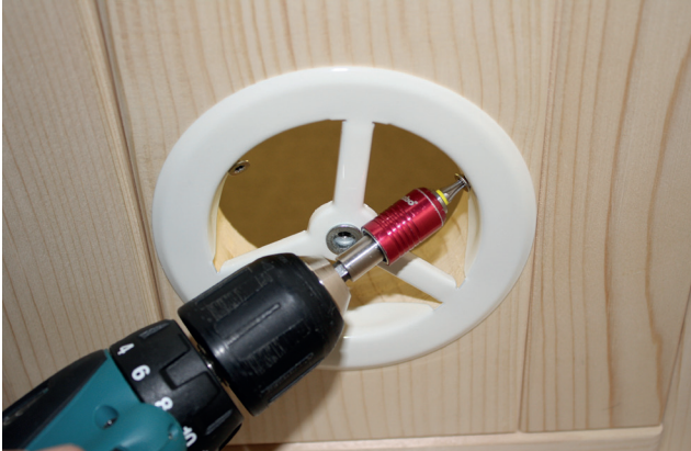
Abb. 36: Montage der Entlüftung
