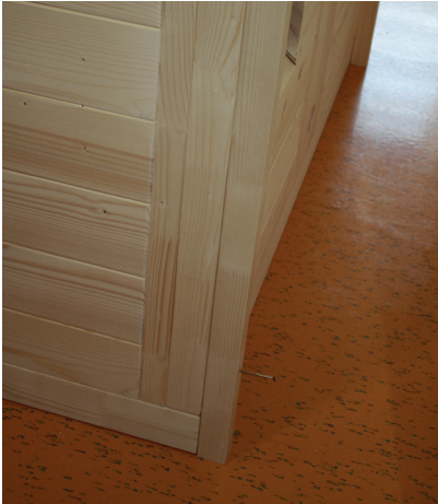
Abb. 52: Montage Abstandleisten Rückwand
