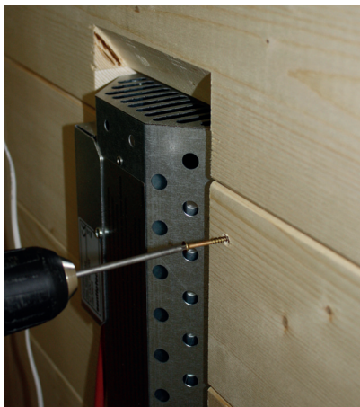
Abb. 42: Blende der Rückenstrahler montieren
