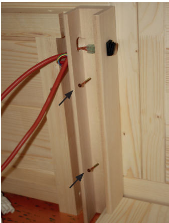
Abb. 33: Montage der U-Leisten für Wärmeplatten
