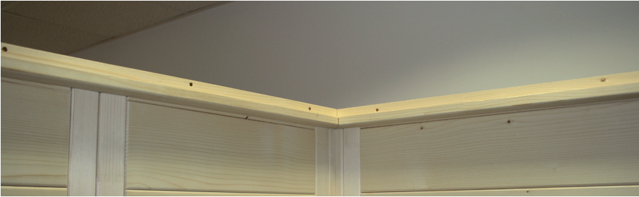
Abb. 17: Einlegen Dachelement hinten mit Lüfterausschnitt
