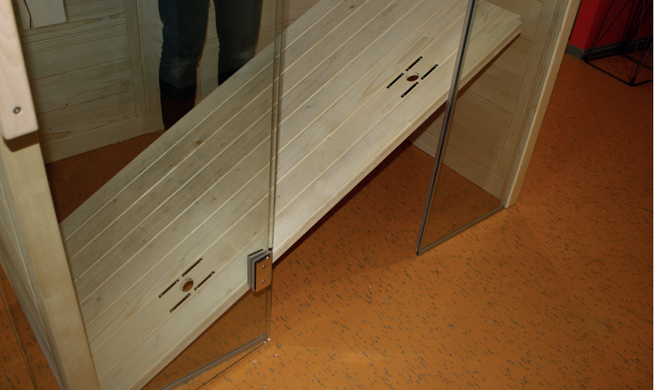
Abb. 28: Kabinenboden einlegen
